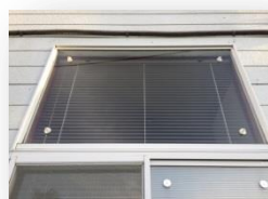
ボルト取付後
