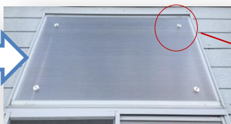
窓枠ごと断熱施工、n=2層化
