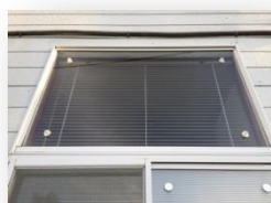
ボルト取付後
