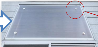
窓枠ごと断熱施工、n=2層化
