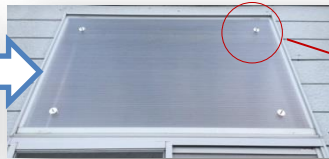
窓枠ごと断熱施工、n=2層化
