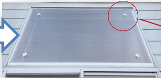
窓枠ごと断熱施工、n=2層化
