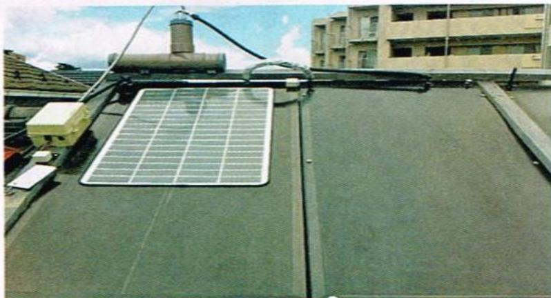
屋根でつくったお湯はポンプで浴室と循環させるが、ポンプを回すには電気が必要。「ヒートル・パネル」の上に太陽光パネルを設置することもできる。
