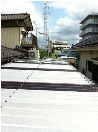
設置前の屋根面
