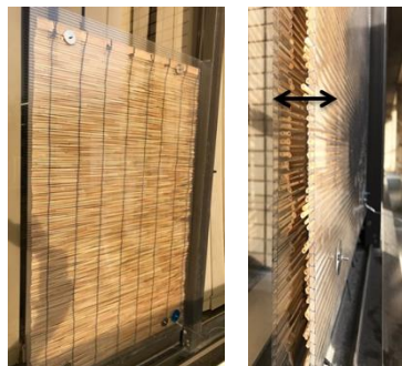
柏市庁舎4階での設置写真 窓と中空ポリカの間にスタダレ挿入
