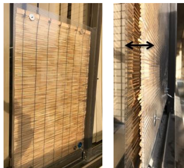
柏市庁舎4階での設置写真 窓と中空ポリカの間にスダレ挿入
