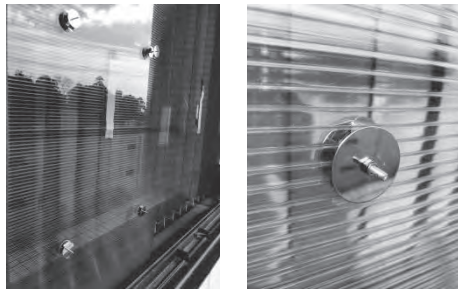
図 23 特殊ボルトとガラス面取付，ポリカ取付柏市役所での実証試験中
