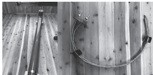
図 21 夏期は上部の暖気を吸引し気化熱冷却
