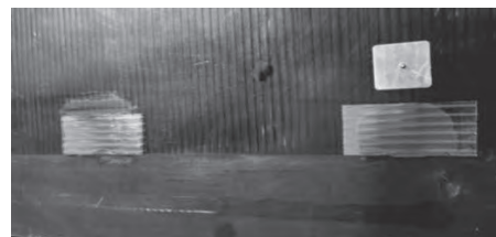
図10 台風の飛散物により穴の開いた2カ所を修理した状況
