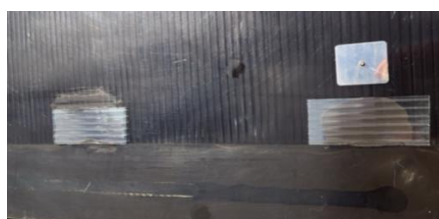
図10 台風の飛散物により穴の開いた2カ所を修理した状況
