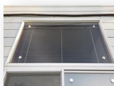
ボルト取付後
